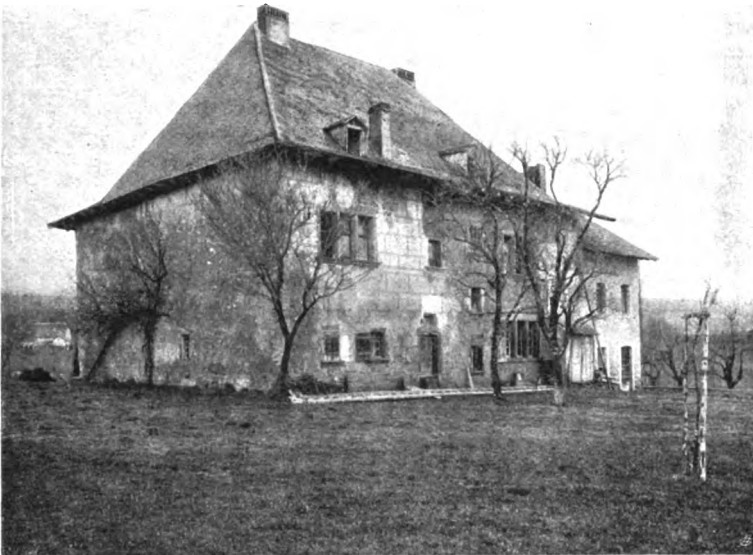
FIG. 243. — La « Grange » de Cuarnens (S. M. H.).
